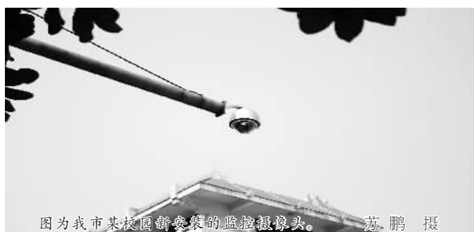
图为我市某校园新安装的监控摄像头。 苏鹏 摄
