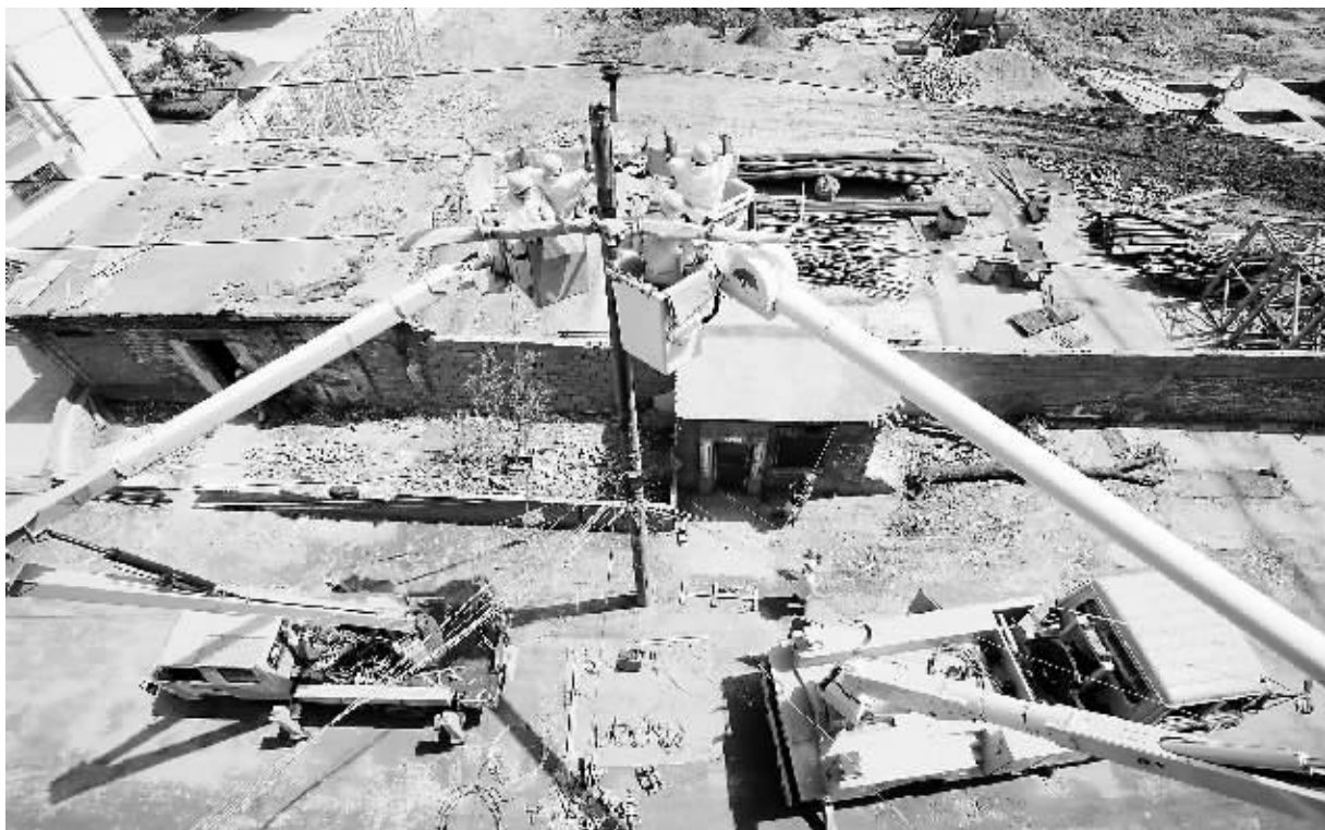
为满足城市开发建设用电需求,提高电网设备运行的可靠性,信阳供电公司于5月10日对10千伏12线预制厂分支线路带电加装隔离开关,避免因停电施工对用户生产生活造成影响,为用户迎峰度夏期间可靠用电提供了保障。
