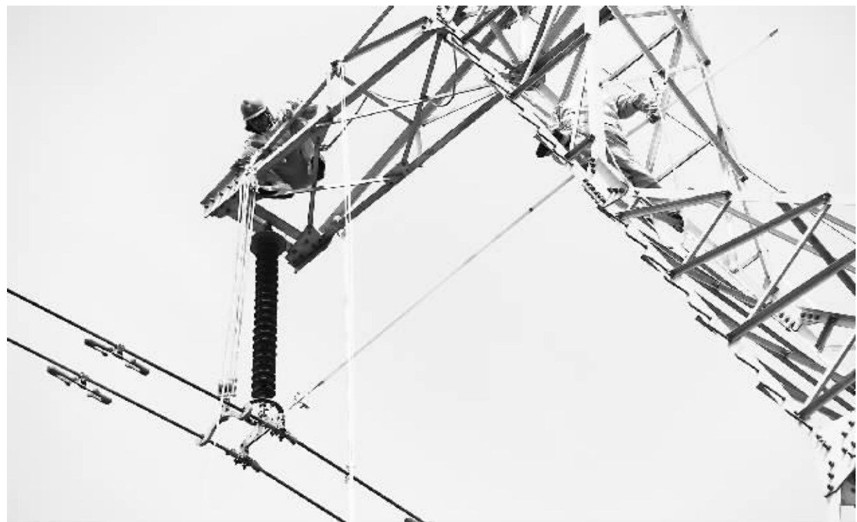
4月16日,信阳供电公司220千伏沙彭线路实施带电消缺作业,成功更换破损绝缘子。此次带电作业避免了该线路3个小时的停电时间,减少停电损失电量近4万千瓦时。
