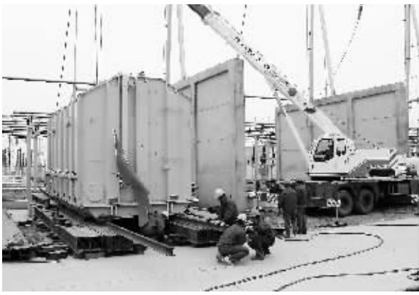
4月6日,500千伏淮河变电站二期扩建工程开工建设。此次扩建工程,将新建一个500千伏主变间隔,两个220千伏母联开关间隔、三个新建线路间隔。扩建后,将进一步提升信阳电网的供电可靠性,为峰期供电提供保障。王强 摄
