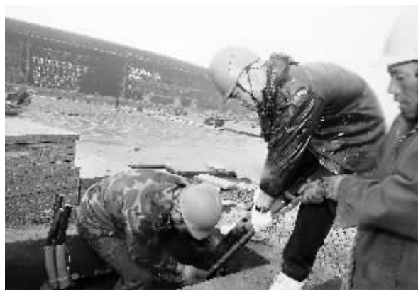
4月11日,信阳供电公司派出52人的施工队伍,冒雨对百花之声会展中心附近10千伏侯5线进行线路拆迁、电缆入地改造,以保证会展中心可靠供电。 杨帆 摄
