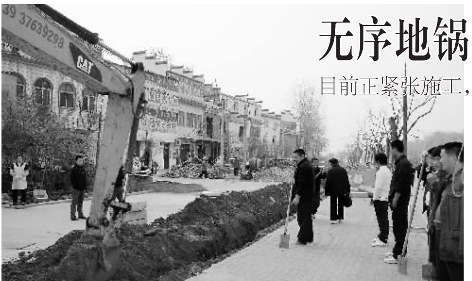
图为正在改造中的南湖风情小吃一条街。
