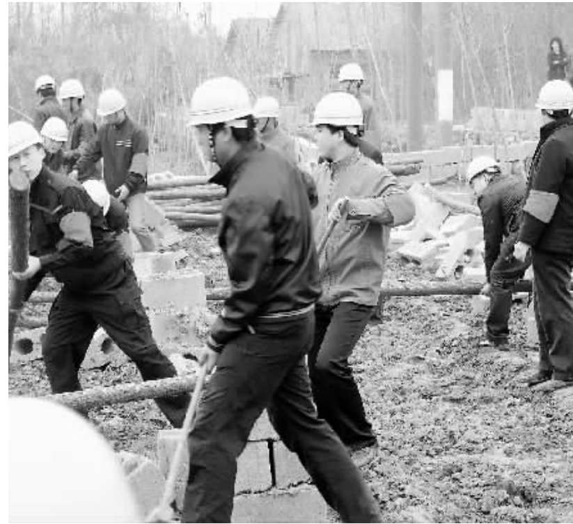
湖河北岸开发建设是惠及信阳人民的好事、实事,涉河区集中人力物力全力服务项目建设,努力保障工程顺利实施。图为日前涉河区五星办事处对违章建筑进行强制拆除时的情景。 刘文强 摄
