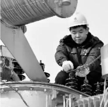
从3月初开始,商城县供电公司充分利用春季设备安全大检查的时机,集中力量对电网进行全面检修维护,以迎接夏季用电高峰的到来。图为3月11日,该公司员工对35千伏丰集变电站2号主变压器进行检修维护。 何萃 摄
