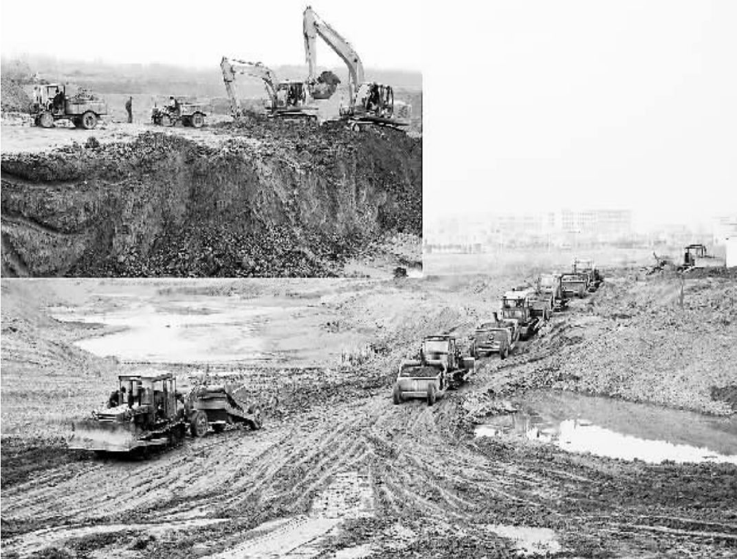
近期,固始县城关镇迅速组织实施郑小河水综合治理工程。农历正月初六以来,该镇组织挖掘机、铲运机、推土机等工程车辆近30辆,投入根亲文化博览园郑小河水综合治理工程施工,实施机械化开挖、疏浚河道,截至目前,已完成土方工程量的50%。图为施工现场。
