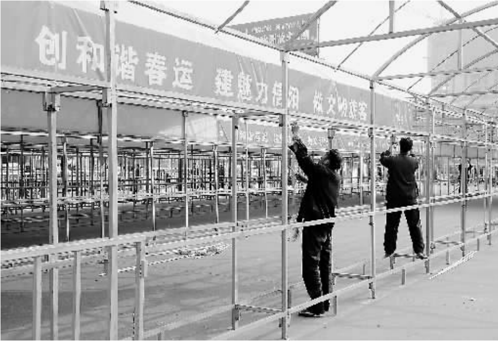
春运即将来临，为方便广大旅客购票、候车，信阳火车站在广场区域搭建临时简易候车棚为旅客遮风挡雨。图为工人们正在搭建候车棚。
