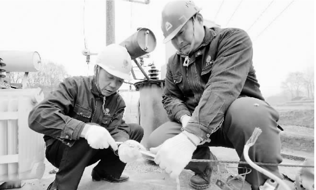
为助推“家电下乡”活动,新县电业局采取措施,确保广大农民用上“放心电”、“安全电”。图为近日该局工作人员对陡山河乡大滩村3号变压器由原50KVA扩容至100KVA施工时的情景。
