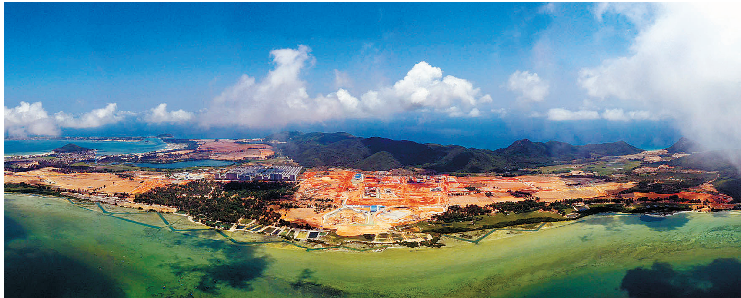
这是正在建设中的海南自由贸易港陵水黎安国际教育创新试验区(4月4日摄,无人机照片)。
