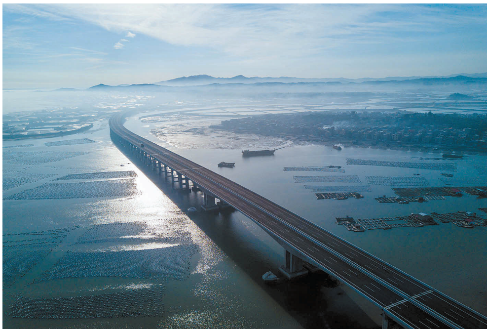
这是12月4日无人机拍摄的福建漳浦佛昙湾跨海特大桥。近年来，福建省漳州市漳浦县大力推进沿海大道建设，加速沿海乡村经济发展。
