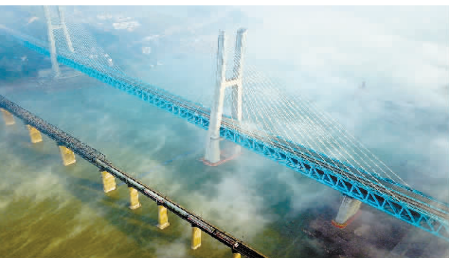
这是1月9日拍摄的新白沙沱长江特大桥(右)和修建于20世纪50年代的白沙沱长江大桥(左)。 经过5年艰苦建设,位于重庆江津的世界首座双层六线钢桁梁铁路斜拉桥——新白沙沱长江特大桥近日落成,与即将开通的渝贵铁路一起进入检测试运行阶段。据介绍,渝贵铁路开通后,列车通过这座大桥最快仅需16.56秒。 新华社记者 刘潺 摄
