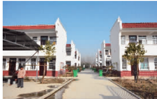
岗李店镇宋庄村易地搬迁集中安置点
