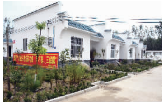
临河乡柿树园易地搬迁集中安置点
