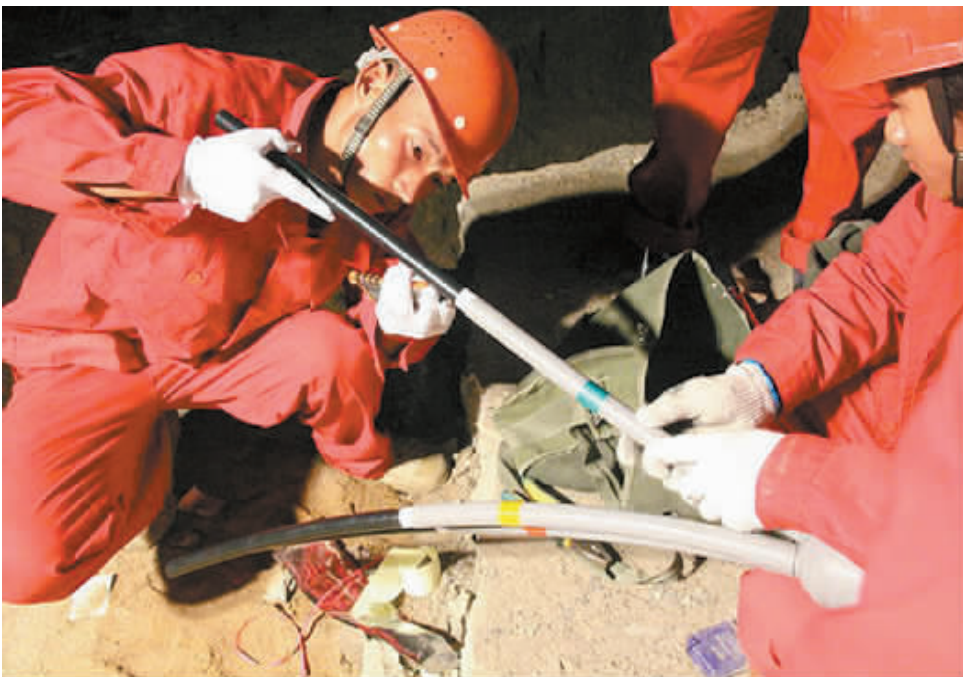
近期,为配合337省道拓宽改造工程,息县供电公司百余名施工人员昼夜不停地加班加点,对S337线电力线路迁改工程进行负荷转移作业。此次电力线路迁改,充分考虑了城区规划及用电负荷发展需求,将极大提高城区供电可靠性和稳定性。图为施工人员夜间在照明灯下加班工作。张星 葛晓宁 摄
